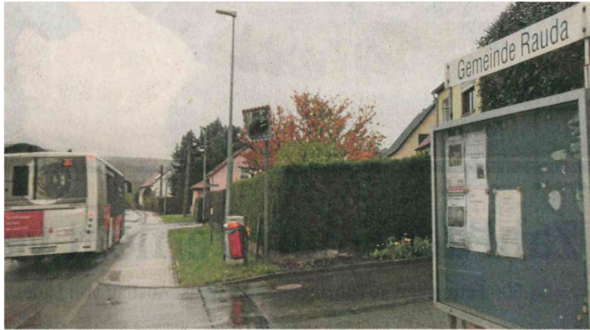
Die Ortsdurchfahrt Rauda soll in 2022 für ein halbes Jahr für Bauarbeiten des Zweckverbandes Trinkwasserversorgung und Abwasserbeseitigung (ZWE) voll gesperrt werden.
